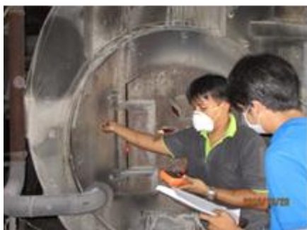
ボイラー壁の測温（タイ）
