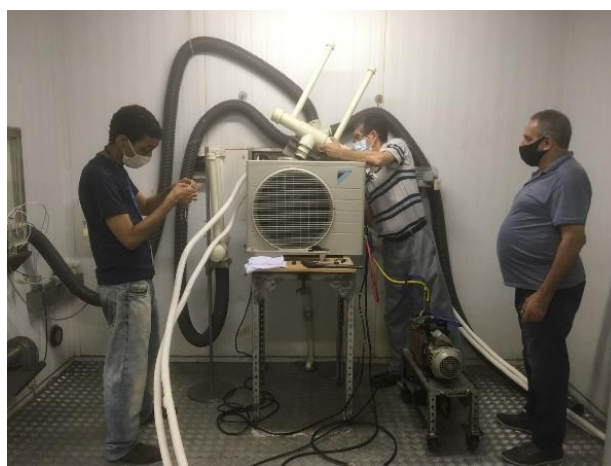
室外機のサンプリング配管の設置
