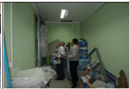
省エネ簡易診断（政府ビル）
