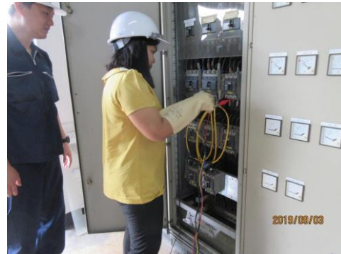
電力計の取り付け状態を確認する診断者
