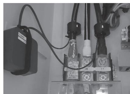
写真-2 「SIRC IoT 電力センサユニット」の設置風景
