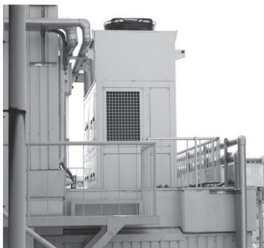
写真-2 狭小部への設置事例
