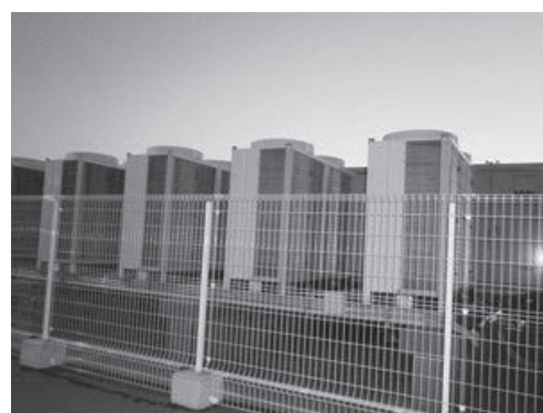
写真-1 エアポレーターシステムを設置前
