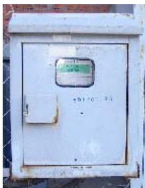
写真 3.4 1 取引用積算電力量計
