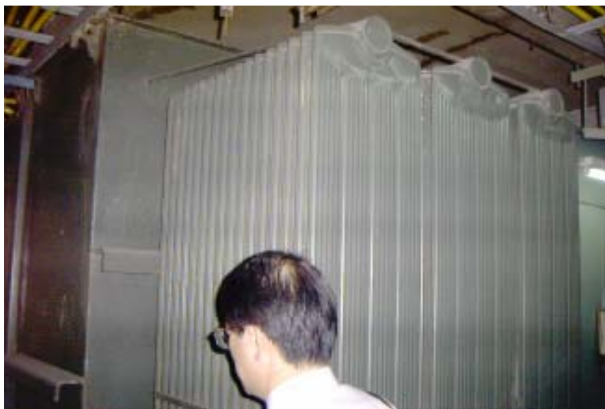
図V－4－16 老朽過大容量変圧器
