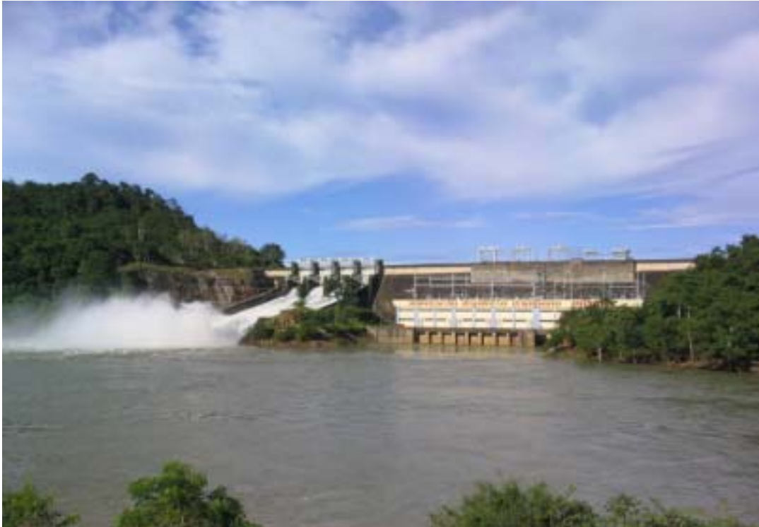
写真 - 3 - 1 Nam Ngum 水力発電所外観
