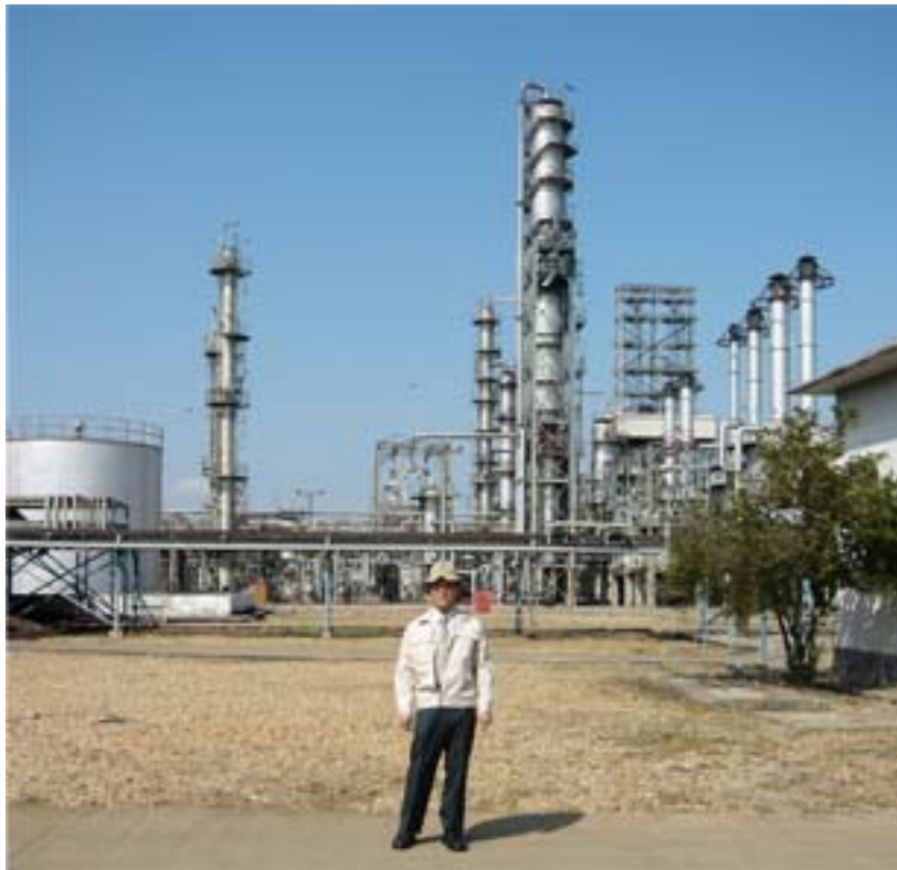
写真 - 3 - 1 タンバヤカン製油所の精製装置(常圧蒸留装置他)
