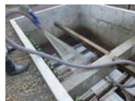
排水を使用した排水ポンプ 当社製品の水洗い洗浄作業
