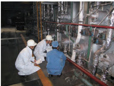
省エネ診断の現場（工業炉の断熱・保温）
