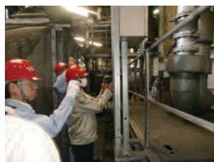
現地ビル診断
