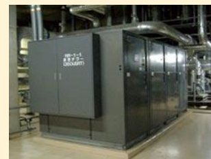
360RT スクリューチラー (3相 400V 70kW4台)
