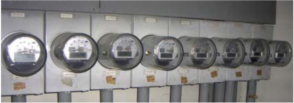
図V-4-2 電力量計量器
