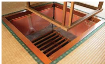
掘りごたつの内側に断熱シートを貼付
